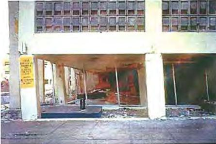
Una losa suave o piso blando puede ser propenso a mayor estrés durante una fuerza externa, aunque no calculemos el esfuerzo, es importante identificar en una construcción para conocer su vulnerabilidad.
