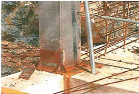
Una junta constructiva en este caso se refiere a la unión de dos elementos de una estructura, en este caso es la junta de una columna de acero con una losa de concreto. Su estado se tiene que evaluar para conocer si existe daño o no
