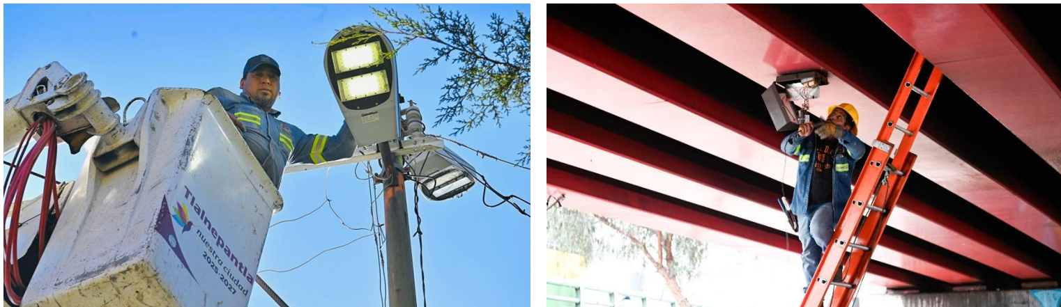
Imagen 42. Mantenimiento al alumbrado público.
